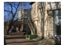
фото №15 Эвакуационный выход 4 группа
