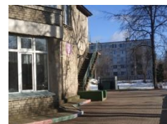
фото №14 Эвакуационный выход 3 группа
