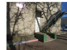
фото №17 Эвакуационный выход 2 группа
